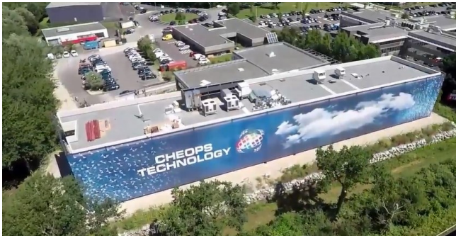
Le siège de Cheops Technology, à Canjan, avec son datacenter
