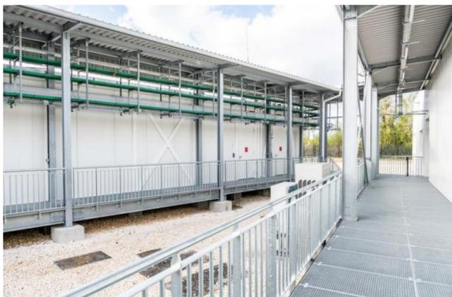
Alimenté à 100% par de l'électricité verte, BX1 est aussi monté sur pilotis et donc « sans impact sur la perméabilité ». Crédit : Equinix
