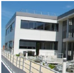
Les bâtiments de Cheops Technology à Bordeaux, Crédit: D.R
